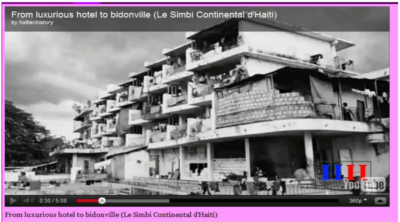
Figure 1.4. Le domaine d'un hôtel de luxe « Le Simbi Continental » a été vandalisé suite à la chute des Duvalier et transformé en un bidonville
