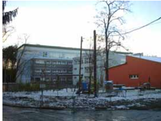
Abb. 28b: Grundschule und Kita in der Nordstadt
