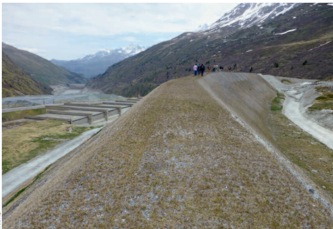
Ein riesiger Damm schützt die Tunneleinfahrt des Grossen St. Bernhard vor Lawinen und Geröll.
