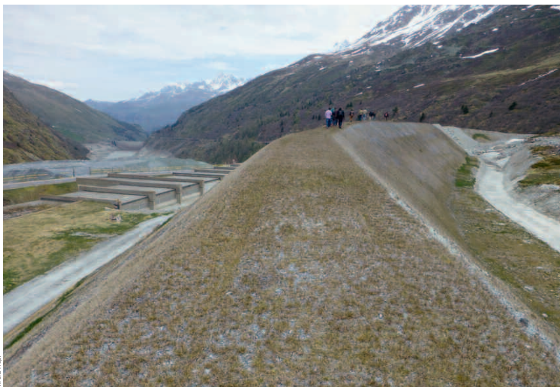
Un imponente argine protegge l'entrata della galleria del Gran San Bernardo da lavine e detriti.
