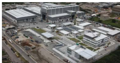
EBN : Base navale zone Nord
